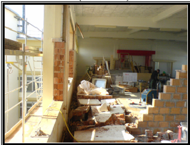
Pendant les travaux (~mars 2006)
